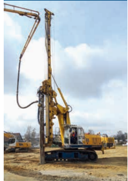
Vibro Concrete Columns VCC
