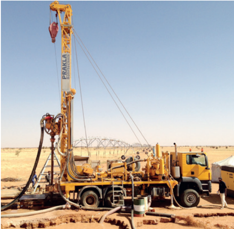
RB 50 beim Bohren von Bewässerungsbrunnen RB 50 drilling irrigation wells
